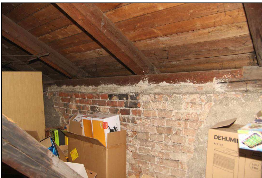
Obr. č. 93 – Prohlídka krovu - pravá část, detail lokálně vyměněné části pozednice
