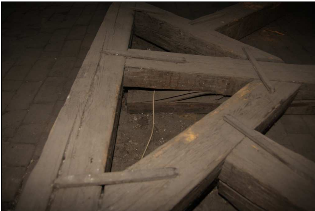
Obr. č. 90 – Prohlídka krovu - střední část, detailní pohled na vazní trám porušený vodorovným lomem,
