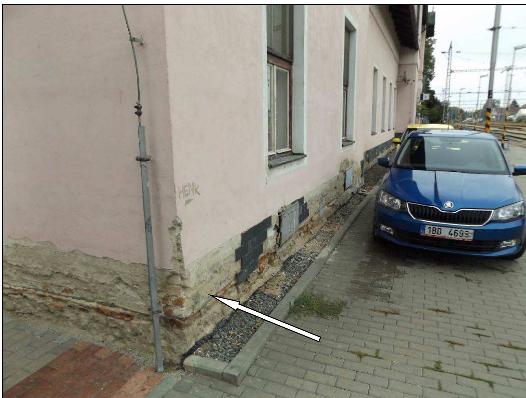
Obr. č. 4 - JZ roh budovy a pohled na J stěnu v pravé části. Vlhkost zdí dosahuje pod parapet oken. U paty zdi patrná dodatečně instalovaná nopová folie proti zemní vlhkosti. V líci zdi je pak patrná dodatečně vložená hydroizolace (viz šipka).
