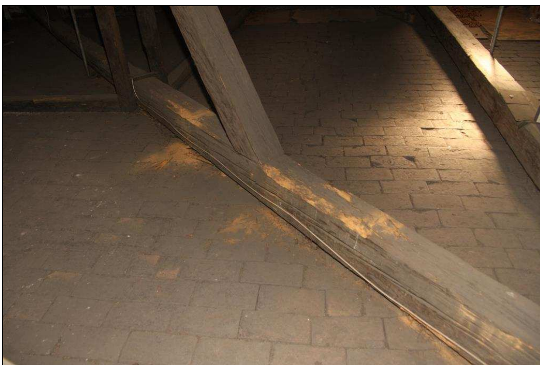
Obr. č. 91 – Prohlídka krovu - střední část, detail poškozeného vazného trámu
