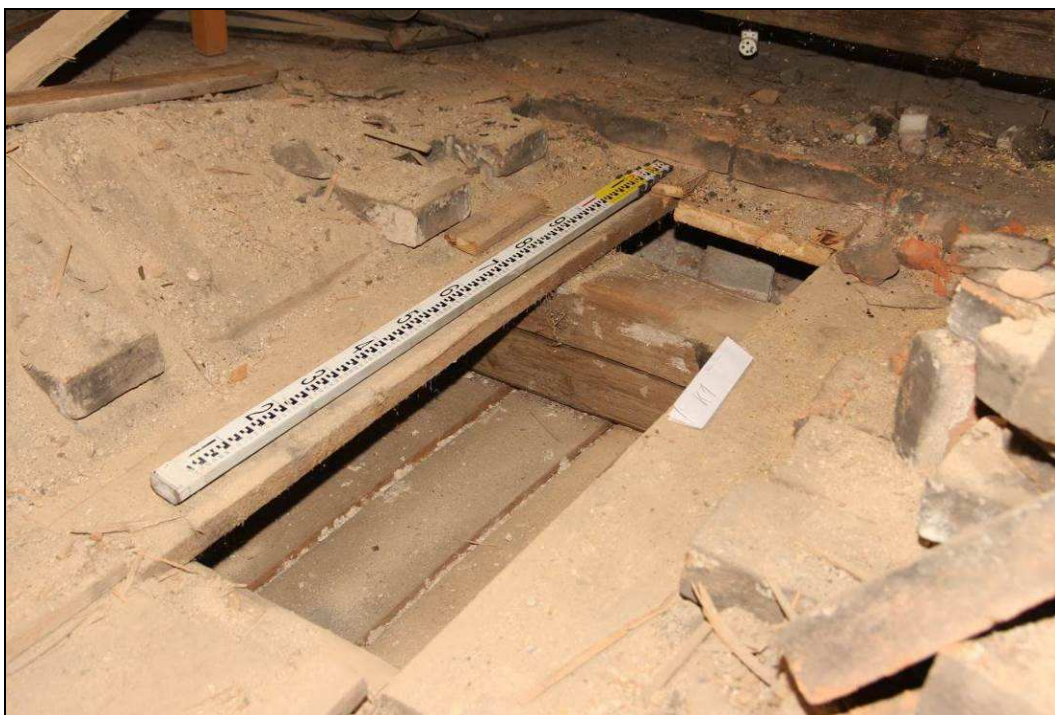
Obr. č. 77 – Sondy do stropních konstrukcí - sonda K1 v podkroví
