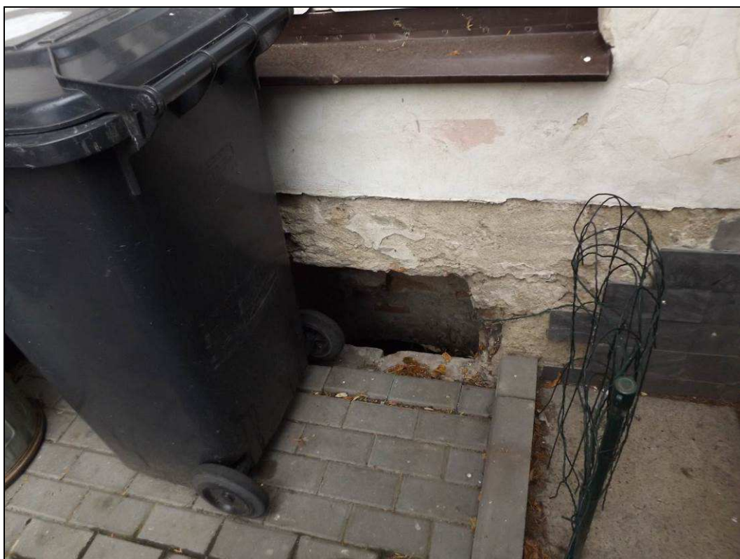
Obr. č. 16 - Okna do sklepa - S obvodová stěna budovy, střední část budovy. Toto okno a vedlejší také je bez výplně a dochází zde k neřízenému větrání a vtoku povrchové vody do sklepa.
