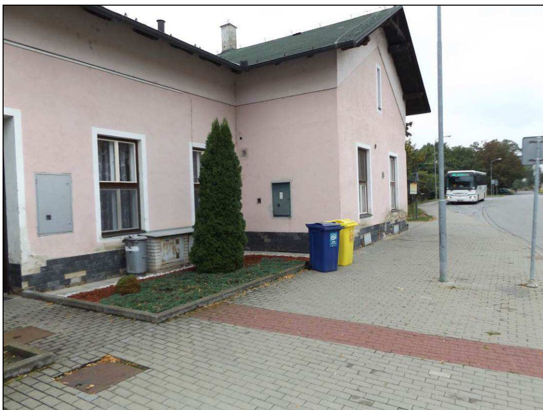
Obr. č. 12 - S obvodová stěna budovy, pravá část budovy. Pata zdí je vlhká a vlhkostní mapy jsou vyšší u nezakrytých, nebo špatně zakrytých oken do sklepa.
