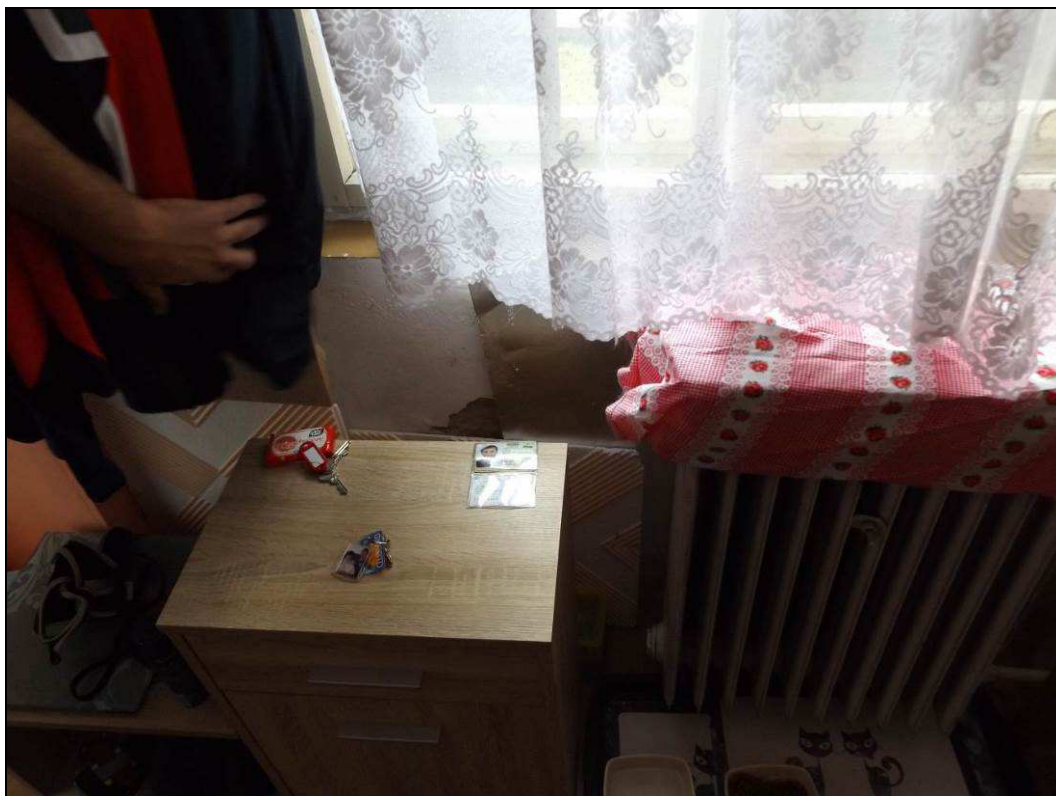
Obr. č. 33 - 1. NP - levá část budovy, M 1.04, vlhká J obvodová zeď do výšky cca 0,5 m
