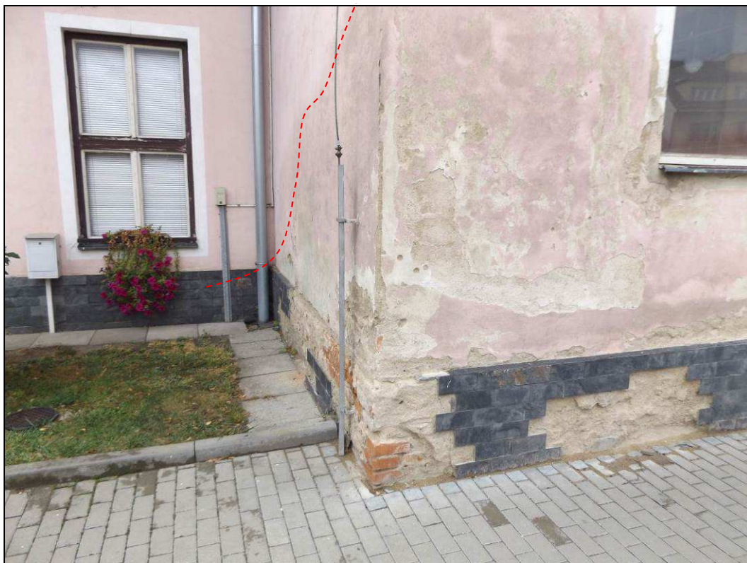
Obr. č. 9 - S obvodová stěna budovy, střední část budovy. Obvodové stěny kolem sociálních místností jdou silně vlhké až do výšky 2,5 m. Dochází zde k opadům omítek a maleb. Okraj vlhkostní mapy červeně.
