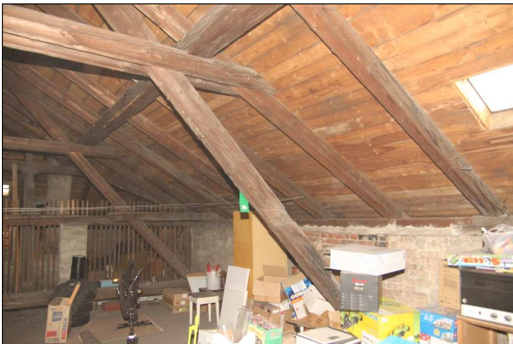
Obr. č. 85 – Prohlídka krovu - Pravá část, chybějící kleštiny, mechanické poškození vzpěry. Na fotce jsou patrná vyměněná prkna
