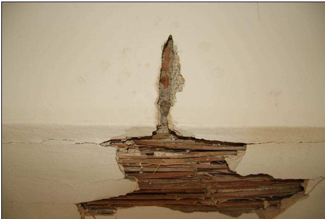
Obr. č. 76 – Sondy do stropních konstrukcí - sonda K8 v 1. NP
