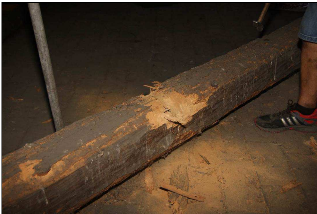
Obr. č. 92 – Prohlídka krovu - střední část, detail do hloubky poškozeného vazného trámu v místě dřívějšího zatékání
