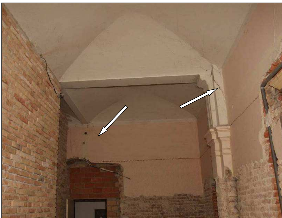
Obr. č. 46 - 1. NP - poruchy stěn - vnitřní zeď mezi M 1.25 a 1.21, diagonální praskliny v líci zdi a pilířů od dosednutí základů
