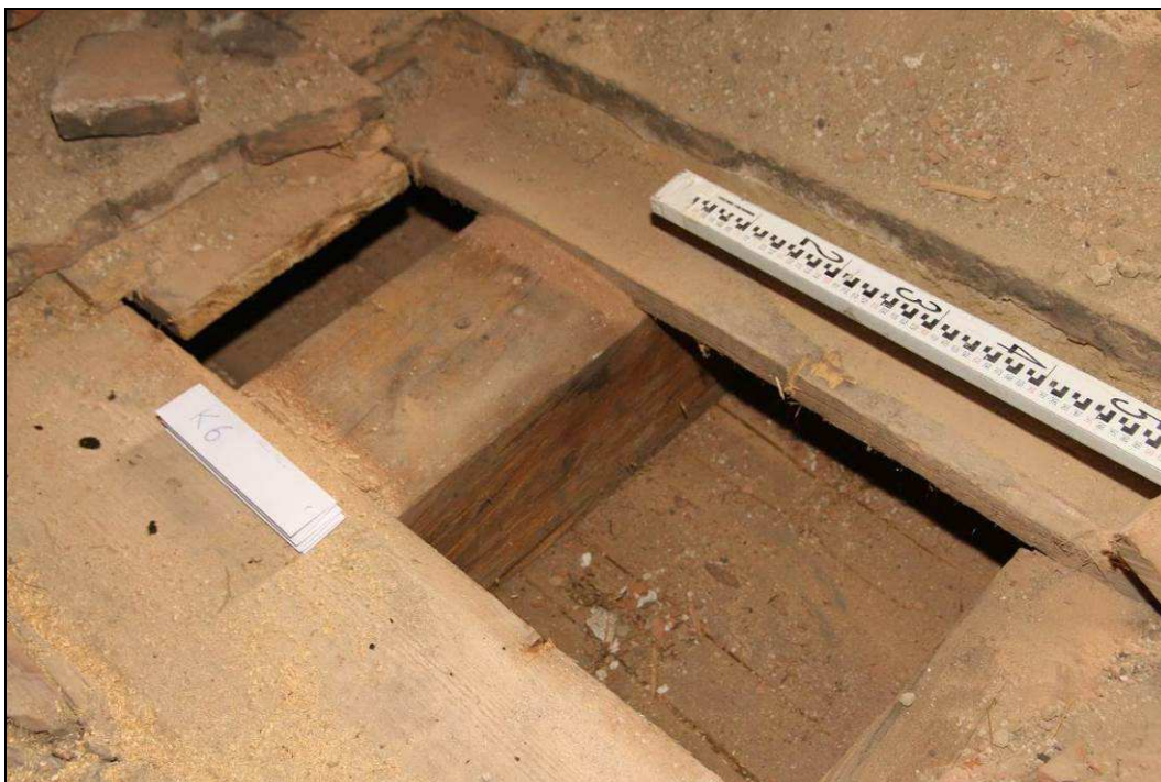
Obr. č. 82 – Sondy do stropních konstrukcí - sonda K6 v podkroví
