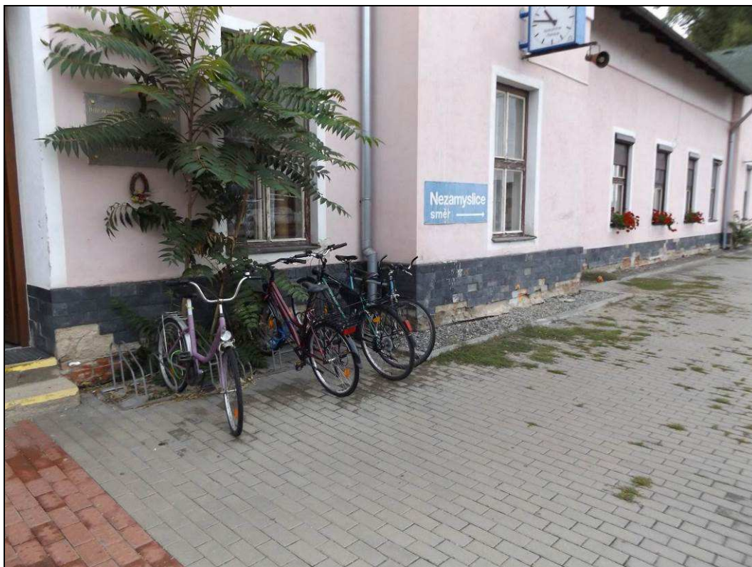
Obr. č. 5 - J obvodová stěna budovy, střední část. Vlhkost zdí dosahuje pod parapet okna. U paty zdi patrná dodatečně instalovaná nopová folie proti zemní vlhkosti
