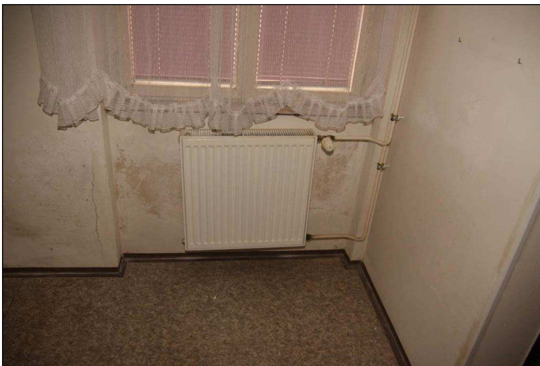
Obr. č. 28 - 1. NP - SZ roh budovy, M 1.57, vlhkost vnější obvodové zdi.
