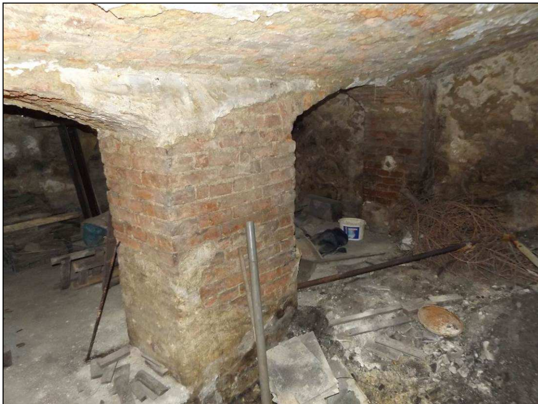
Obr. č. 25 - 1. PP - sklep v levé části budovy. Pilíř z cihlového zdiva. Zde je podlaha částečně z betonu.
