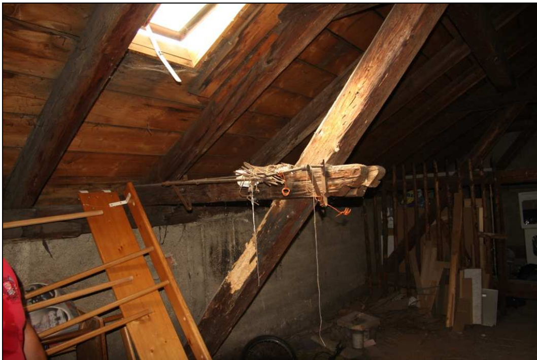
Obr. č. 86 – Prohlídka krovu - Pravá část, mechanicky poškozená kleština, do hloubky poškozená vzpěra v místě dřívějšího zatékání
