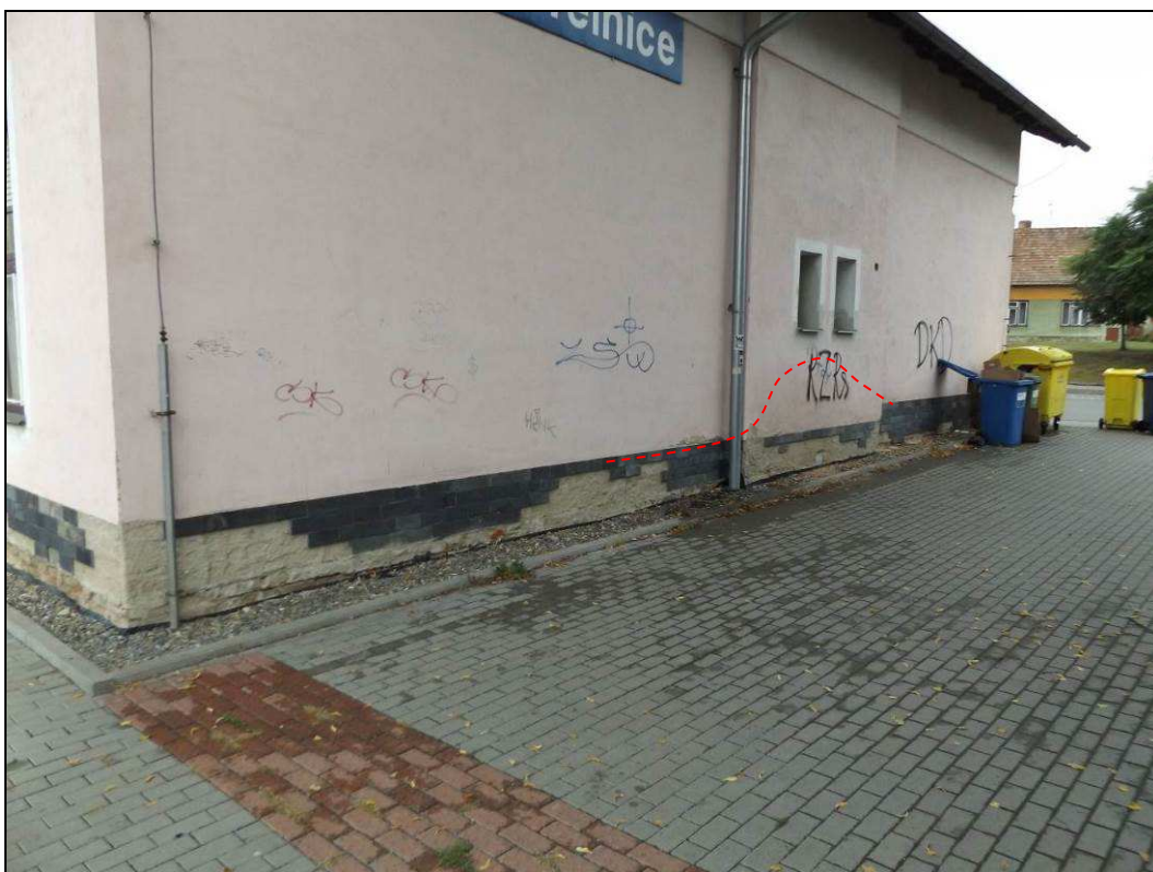
Obr. č. 8 - JV roh a V obvodová stěna budovy, levá část budovy. U paty zdi je dodatečně instalovaná nopová folie proti zemní vlhkosti. Vlhkost zdiva je v úrovni kamenného obkladu stěn, v místě sociálních místností vystupuje pod úroveň oken, viz červená čára.
