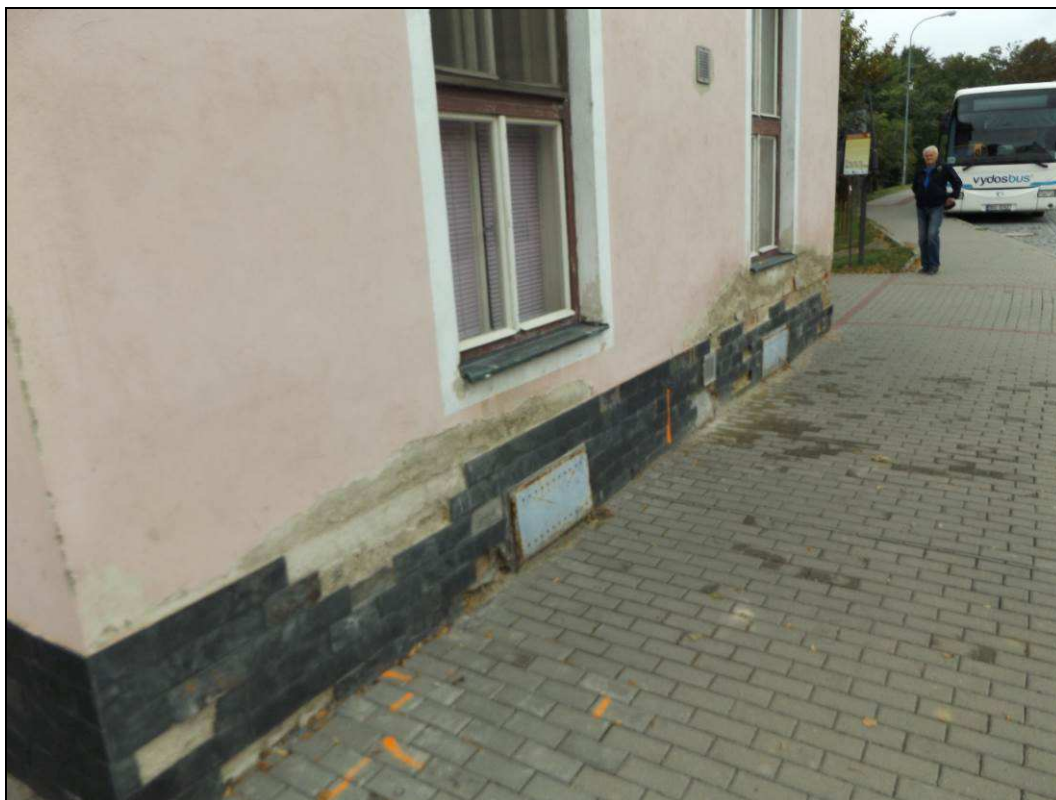
Obr. č. 17 - Okna do sklepa - S obvodová stěna budovy, pravá část budovy. Okna do tohoto sklepa jsou s plechovými okenními křídly, která nedostatečně sklep izolují.
