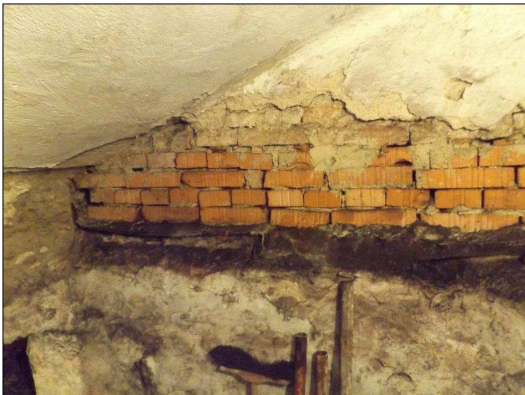
Obr. č. 38 - 1. NP - dodatečně vložená izolace ve vnitřních prostorech - vstup do sklepa ve střední části
