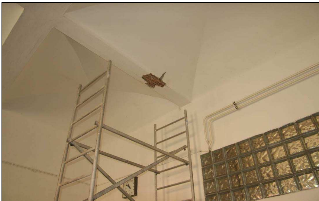
Obr. č. 74 – Sondy do stropních konstrukcí - realizace sondy K8 v 1. NP
