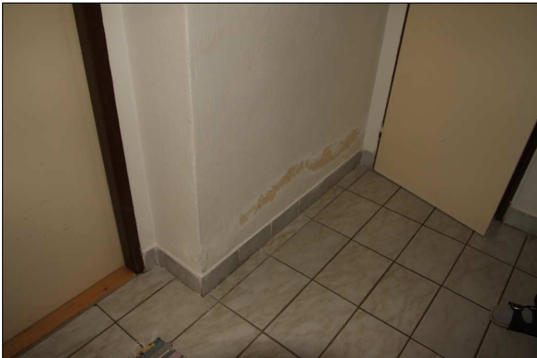
Obr. č. 35 - 1. NP - střední část budovy, M 1.28, vlhká vnitřní zeď do výšky 0,3 m
