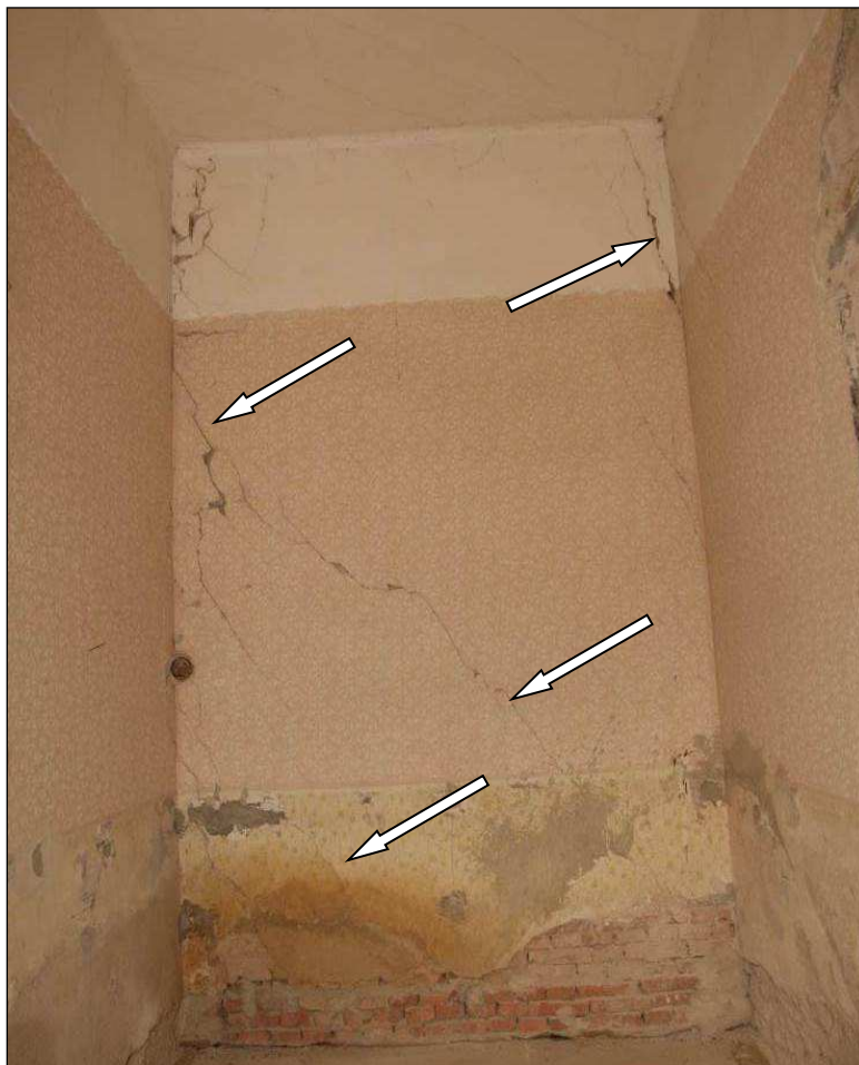
Obr. č. 45 - 1. NP - poruchy stěn - vnitřní zeď mezi M 1.26 a 1.24, diagonální praskliny v líci zdi od dosednutí základů
