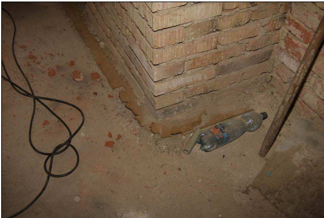
Obr. č. 41 - 1. NP - dodatečně vložená izolace ve vnitřních prostorech - M1.25a, detailní pohled na izolaci pod patou stěny.
