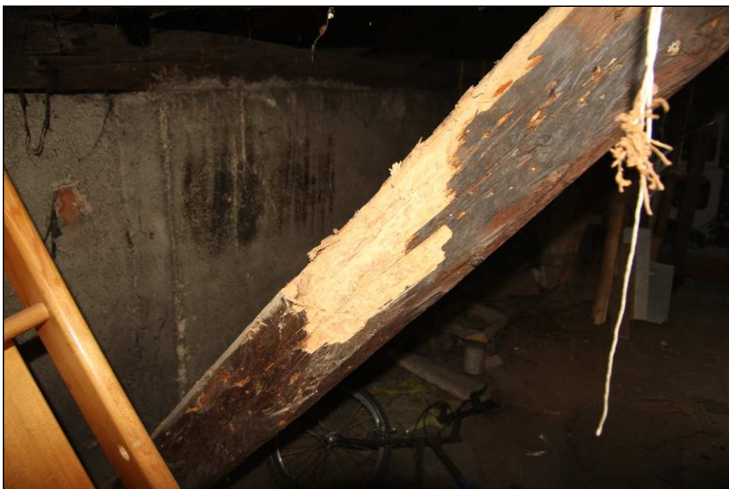
Obr. č. 87 – Prohlídka krovu - Pravá část, detail poškozené vzpěry
