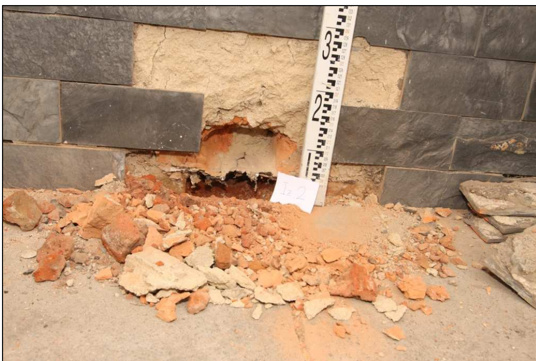
Obr. č. 56 – ověření vodorovné izolace v místě Iz 2.
