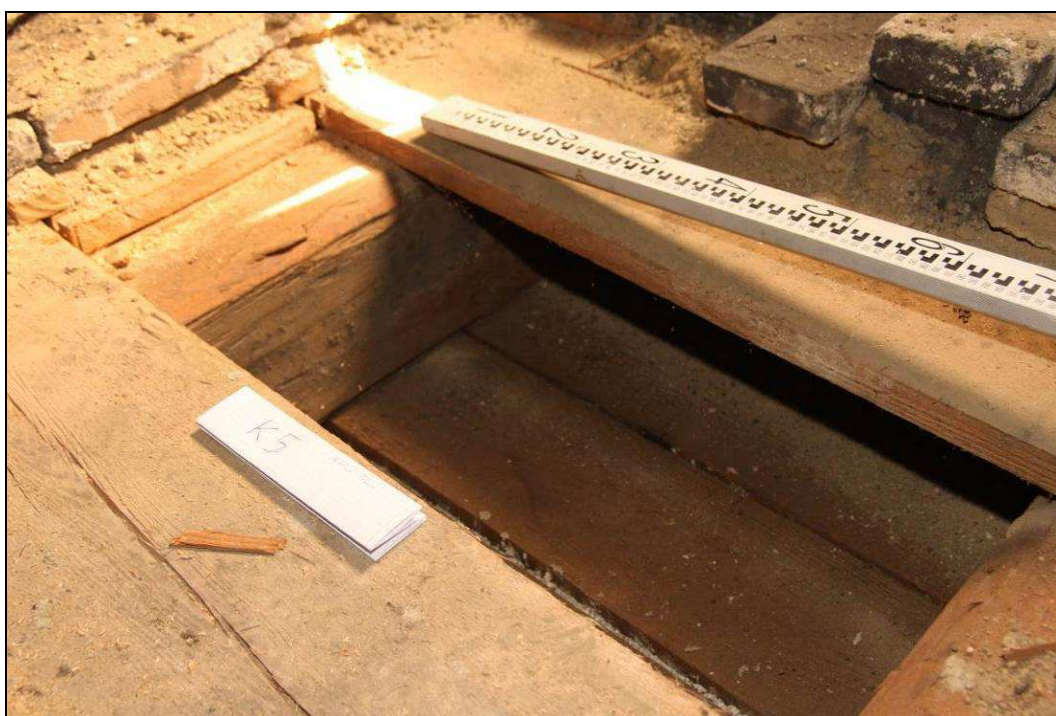
Obr. č. 81 – Sondy do stropních konstrukcí - sonda K5 v podkroví
