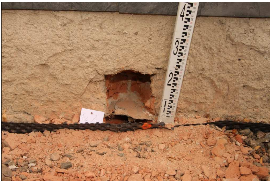
Obr. č. 61 – ověření vodorovné izolace v místě Iz 7.
