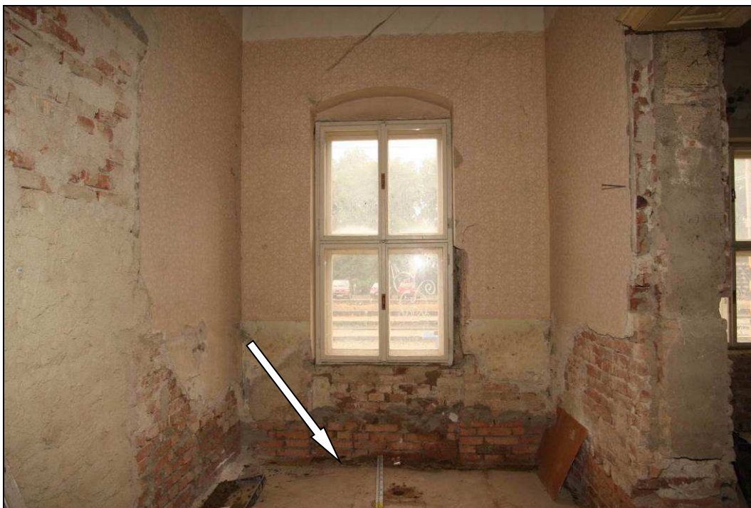
Obr. č. 40 - 1. NP - dodatečně vložená izolace ve vnitřních prostorech - M1.26, dodatečně vložená izolace do vnější obvodové stěny po celém obvodu stěn místnosti. Poloha izolace viz šipka.
