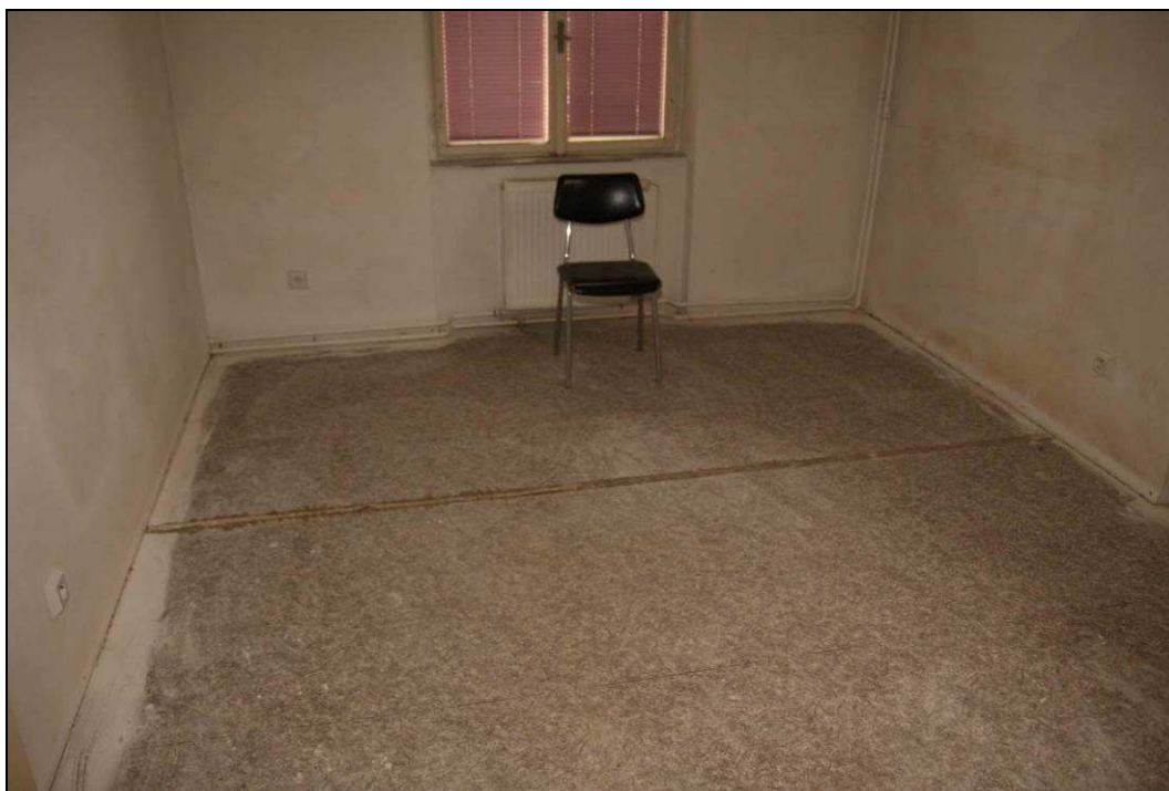
Obr. č. 30 - 1. NP - JZ roh budovy, M 1.65, dřevěné podlahy jsou vypouklé a prošlapané.
