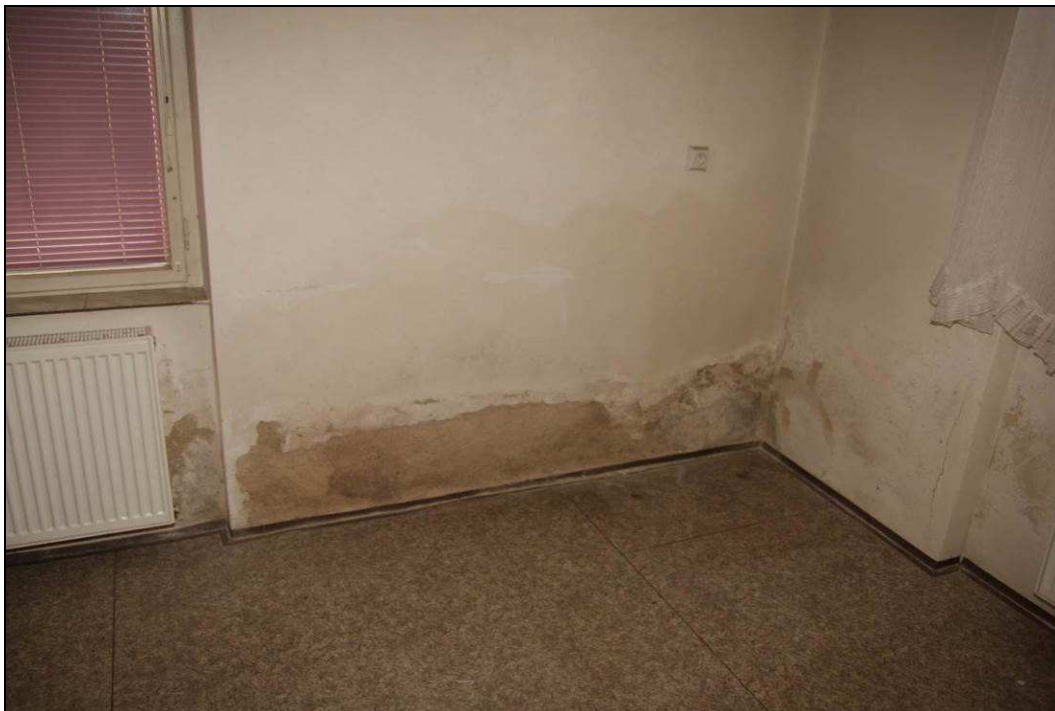
Obr. č. 27 - 1. NP - SZ roh budovy, M 1.57, vlhkost vnější obvodové zdi.
