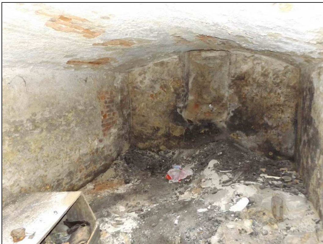
Obr. č. 19 - 1. PP - sklep v pravé části budovy. Typický obrázek. Omítka na zdivu je silně degradovaná a opadává.
