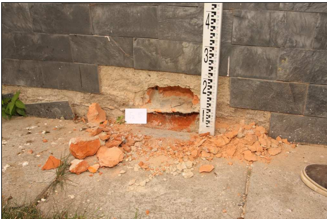
Obr. č. 59 – ověření vodorovné izolace v místě Lz 5.
