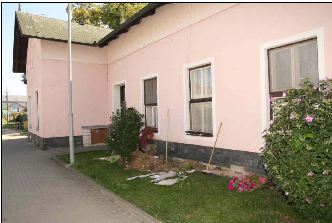
Obr. č. 49 - kopané sondy u líce zdiva, sonda KS2
