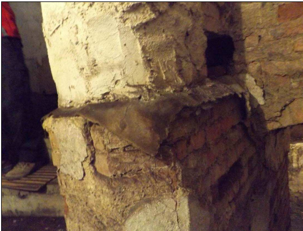
Obr. č. 21 - 1. PP - sklep ve střední části budovy. Dodatečně vložená izolace do schodišťové zdiv.
