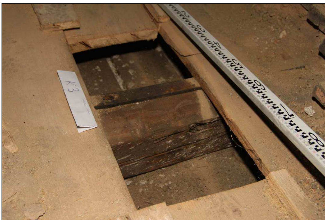
Obr. č. 79 – Sondy do stropních konstrukcí - sonda K3 v podkroví
