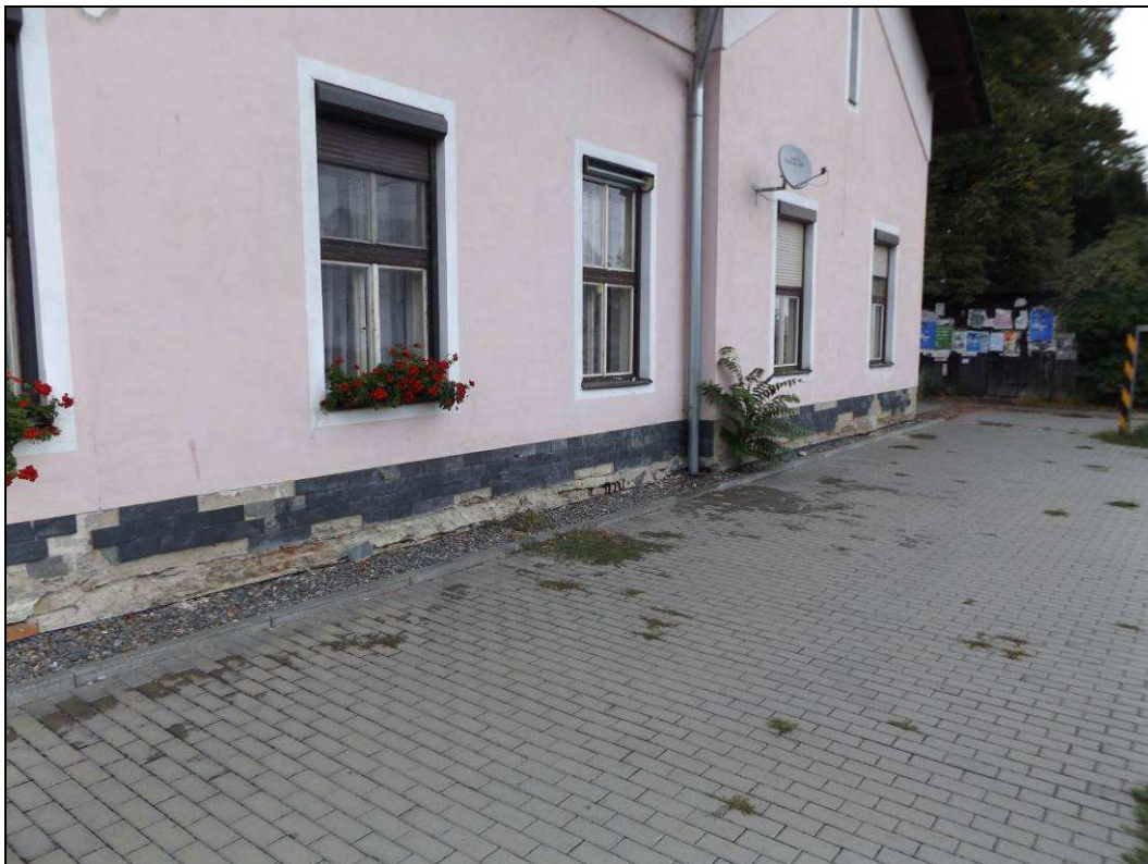
Obr. č. 7 - obvodová stěna budovy, levá část budovy. U paty zdi patrná dodatečně instalovaná nopová folie proti zemní vlhkosti. Vlhkost zdiva je v úrovni kamenného obkladu stěn.
