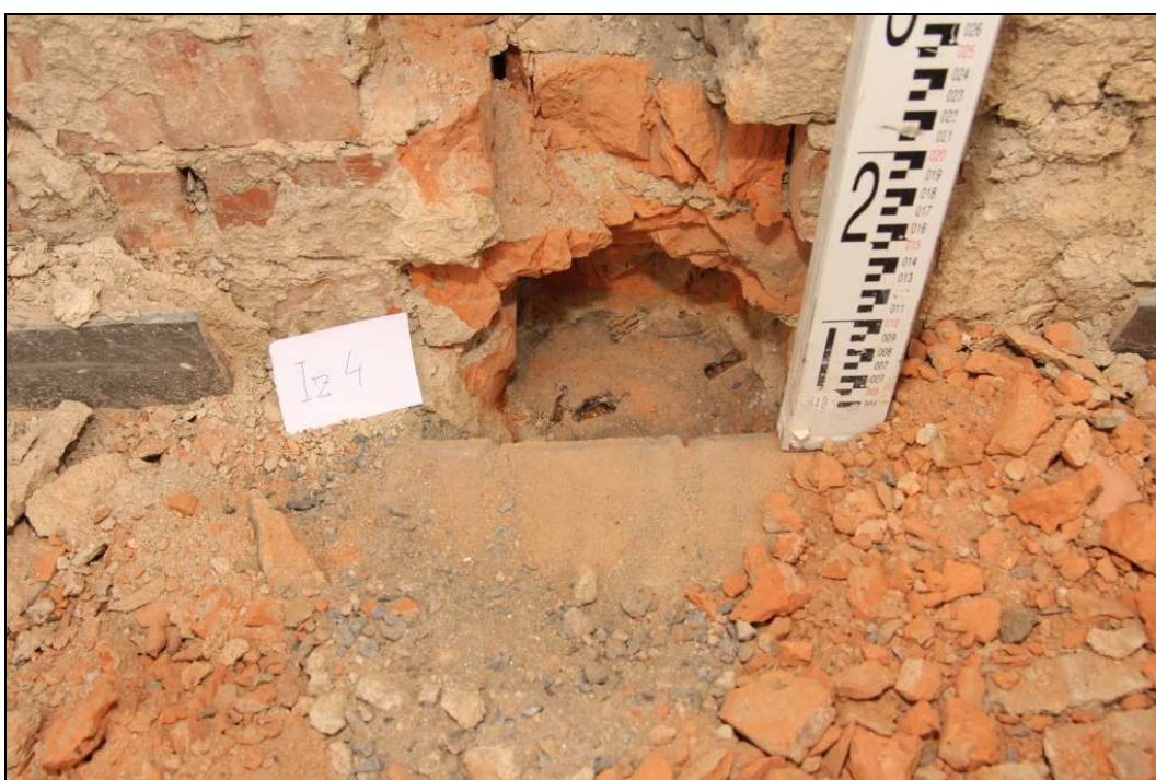
Obr. č. 58 – ověření vodorovné izolace v místě Iz 4.
