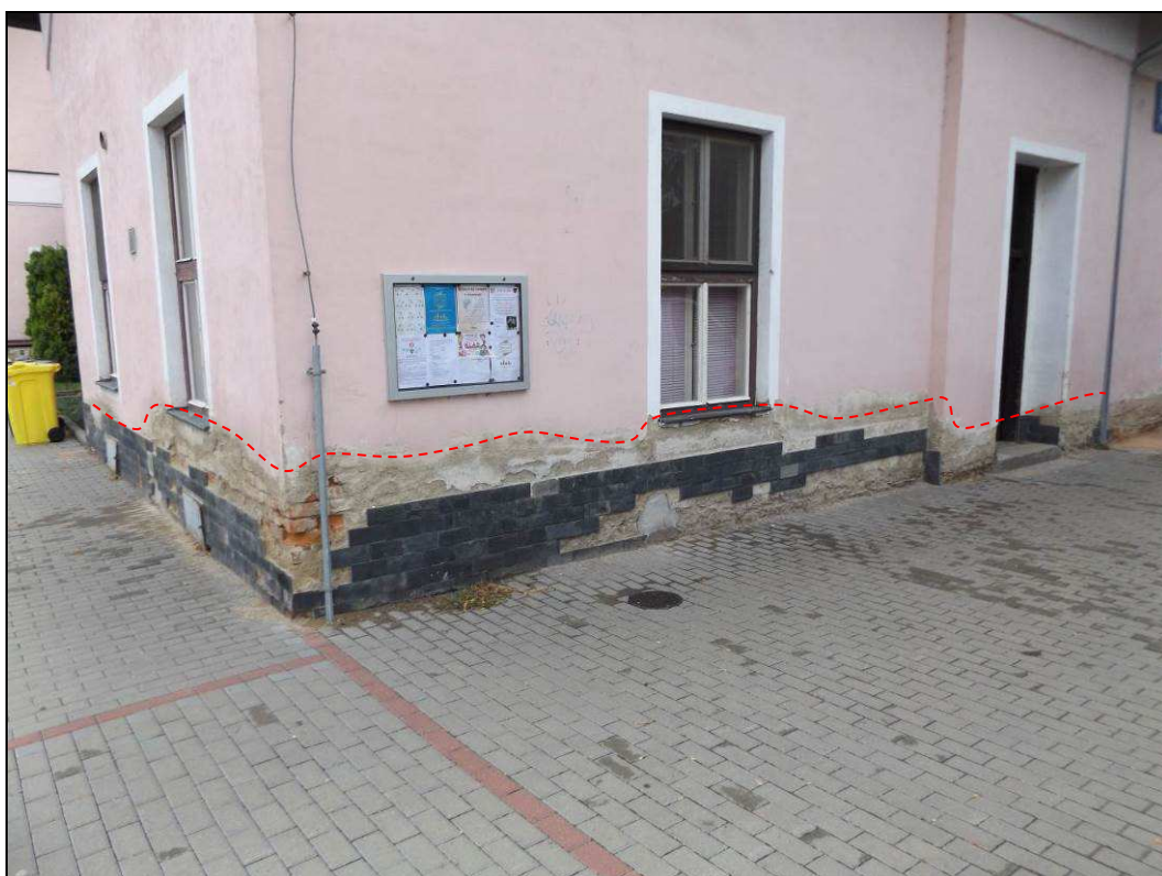
Obr. č. 2 - SZ roh budovy, vlhkost zdi dosahuje k parapetům oken, horní okraj vlhkostních map vyznačen červeně
