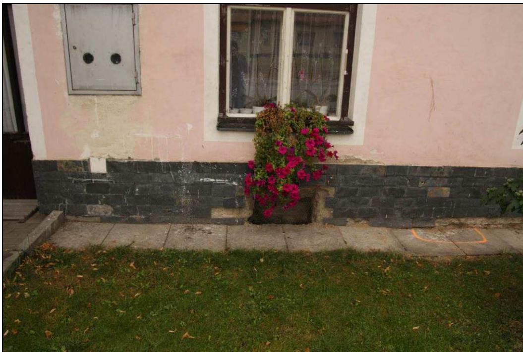
Obr. č. 14 - Okna do sklepa - S obvodová stěna budovy, levá část budovy. Toto okno je bez výplně a dochází k neřízenému větrání a vtoku povrchové vody do sklepa.
