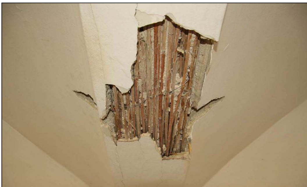
Obr. č. 75 – Sondy do stropních konstrukcí - sonda K8 v 1. NP
