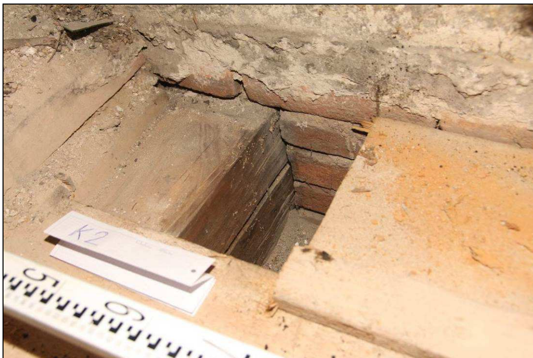
Obr. č. 78 – Sondy do stropních konstrukcí - sonda K2 v podkroví
