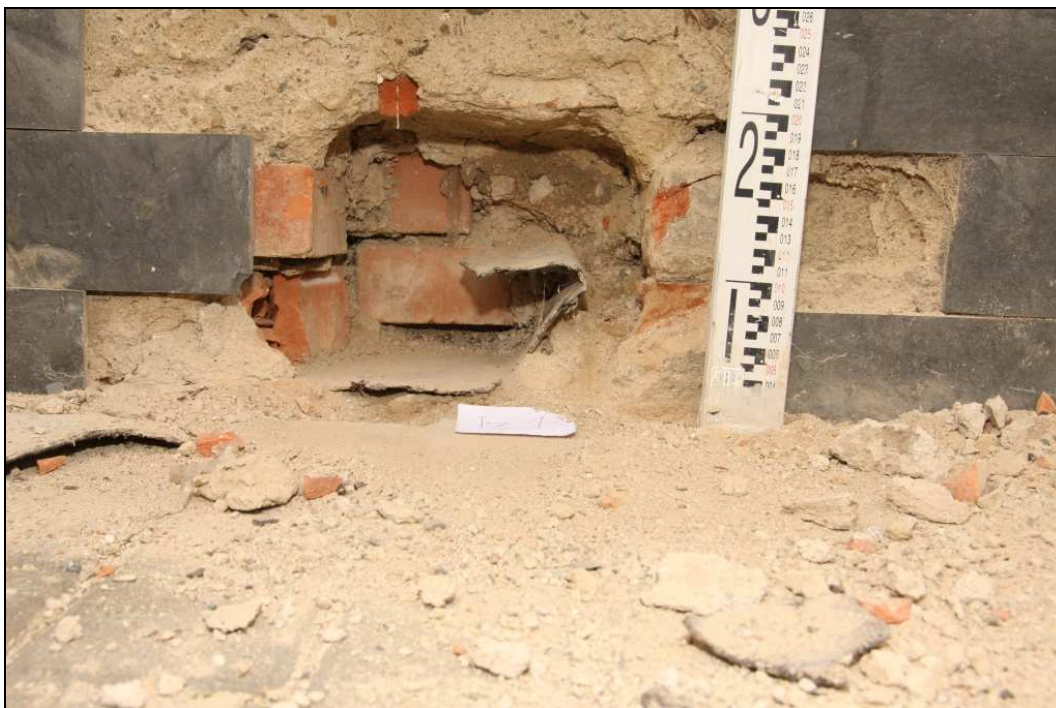
Obr. č. 55 – ověření vodorovné izolace v místě Iz 1
