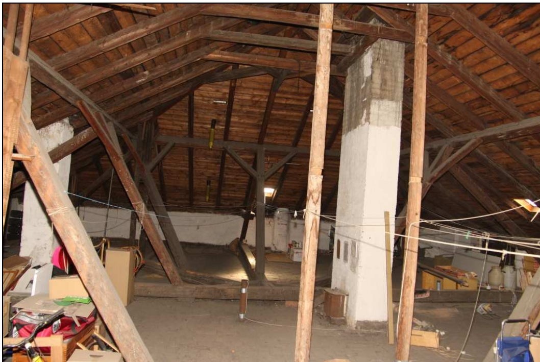
Obr. č. 88 – Prohlídka krovu - střední část, celkový pohled k východu. Ve vyšších partiích je patrné poškození prken od zatékání
