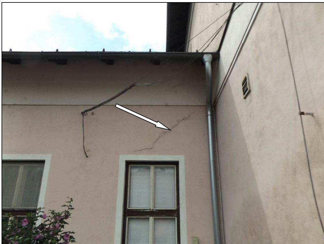
Obr. č. 43 - 1. NP - poruchy stěn - S obvodová zeď, diagonální praskliny v líci zdi od dosednutí základů
