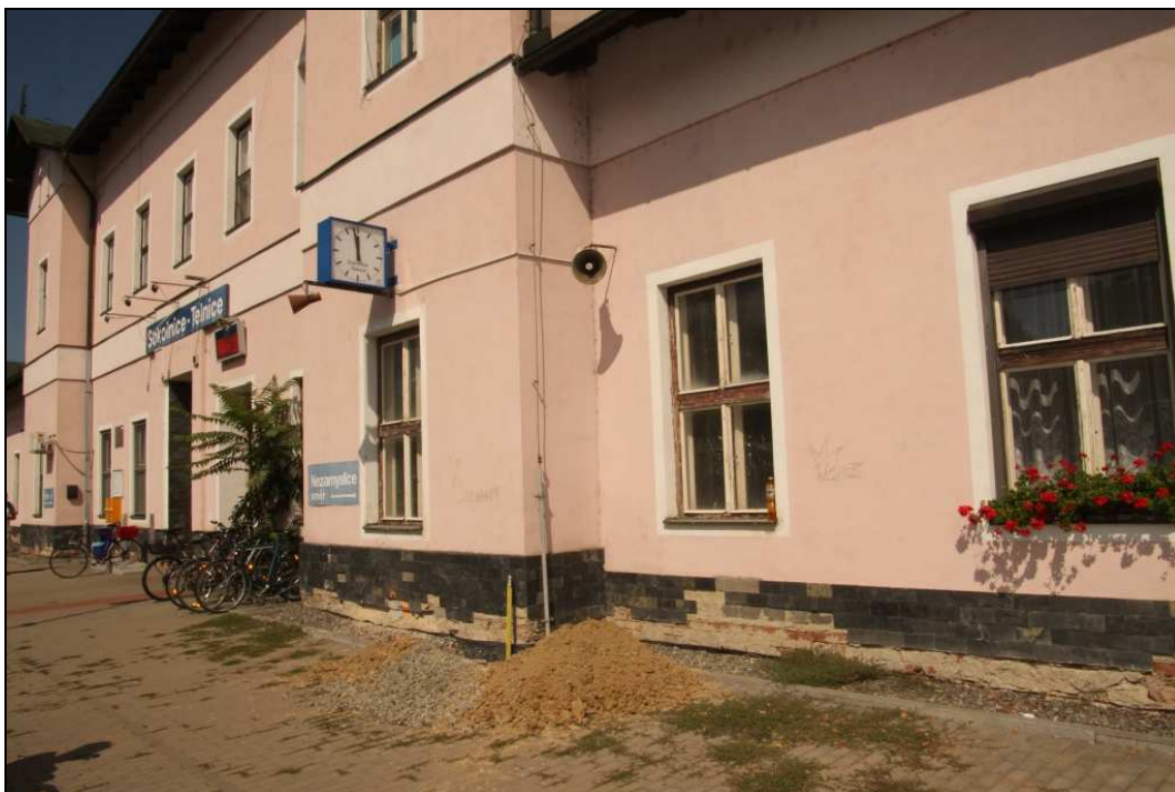
Obr. č. 51 - kopané sondy u líce zdiva, sonda KS3
