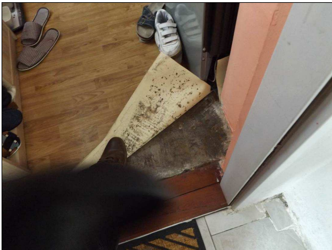
Obr. č. 31 - 1. NP - pravá část budovy, M 1.38, vlhká betonová podlaha.
