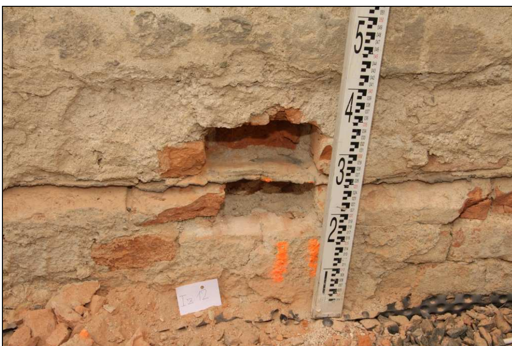
Obr. č. 66 – ověření vodorovné izolace v místě Iz 12.
