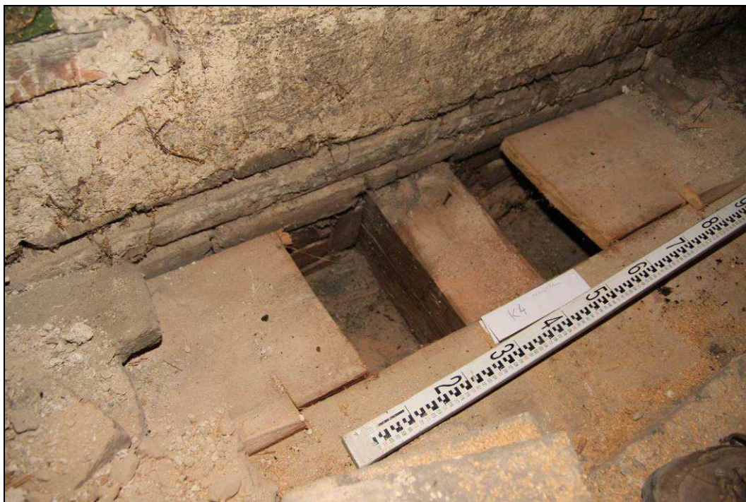
Obr. č. 80 – Sondy do stropních konstrukcí - sonda K4 v podkroví
