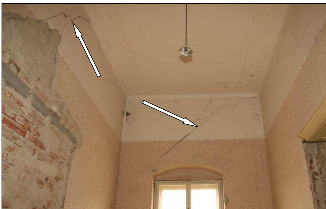
Obr. č. 44 - 1. NP - poruchy stěn - J obvodová a vnitřní zeď v M1.26, diagonální praskliny v líci zdi od dosednutí základů
