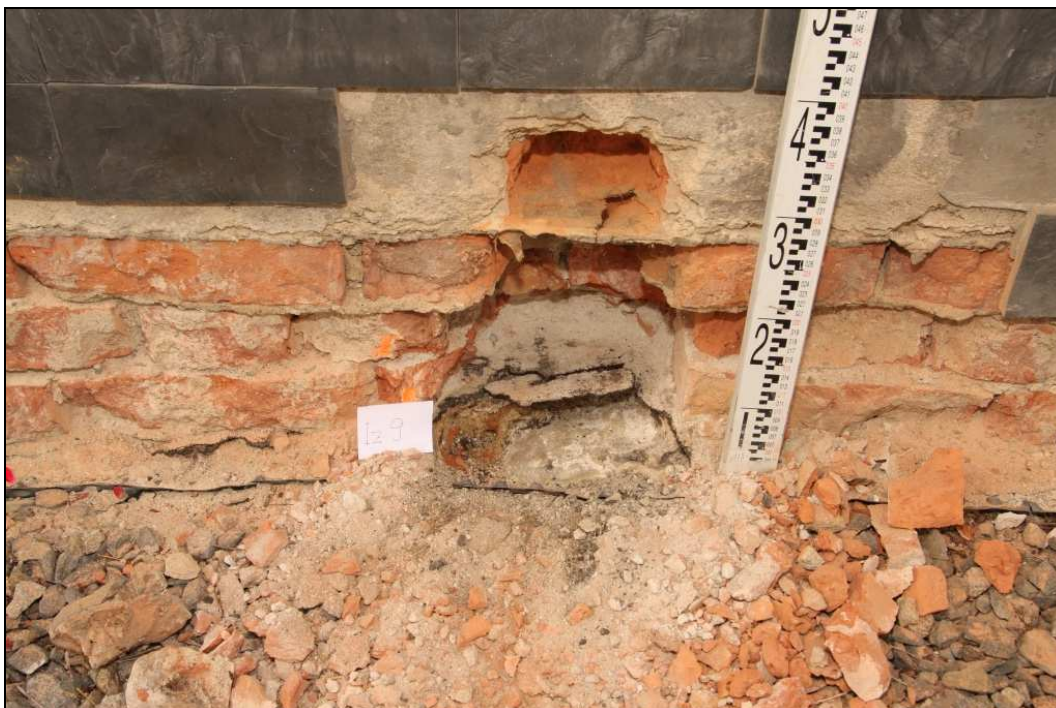
Obr. č. 63 – ověření vodorovné izolace v místě Iz 9.
