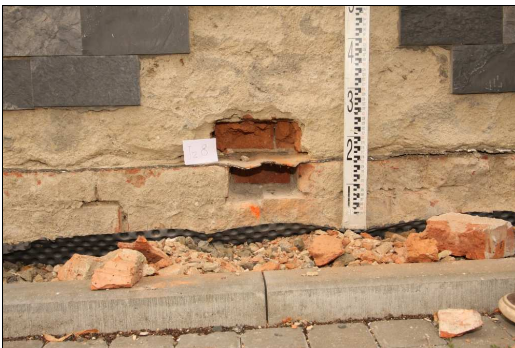
Obr. č. 62 – ověření vodorovné izolace v místě Iz 8.
