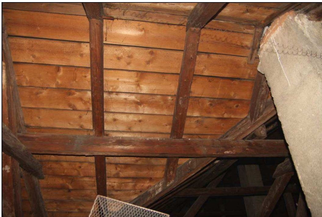
Obr. č. 93 – Prohlídka krovu - levá část, pohled na úžlabí a v místě komína poškozené krokve
