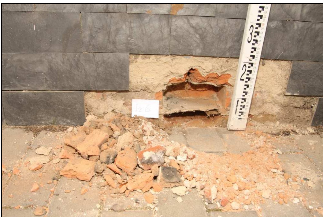
Obr. č. 60 – ověření vodorovné izolace v místě Lz 6.
