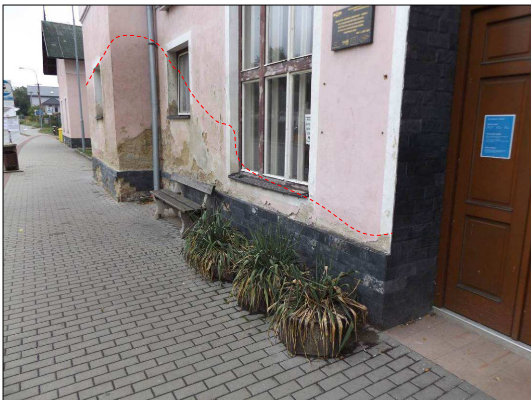
Obr. č. 10 - S obvodová stěna budovy, střední část budovy. Obvodové stěny kolem sociálních místností jdou silně vlhké až do výšky 2,5 m. Dochází zde k opadům omítek a maleb. Okraj vlhkostní mapy červeně.
