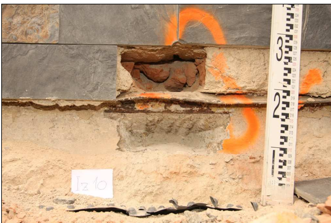
Obr. č. 64 – ověření vodorovné izolace v místě Iz 10.
