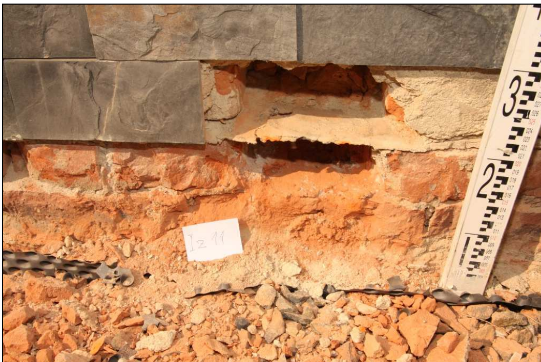
Obr. č. 65 – ověření vodorovné izolace v místě Iz 11.
