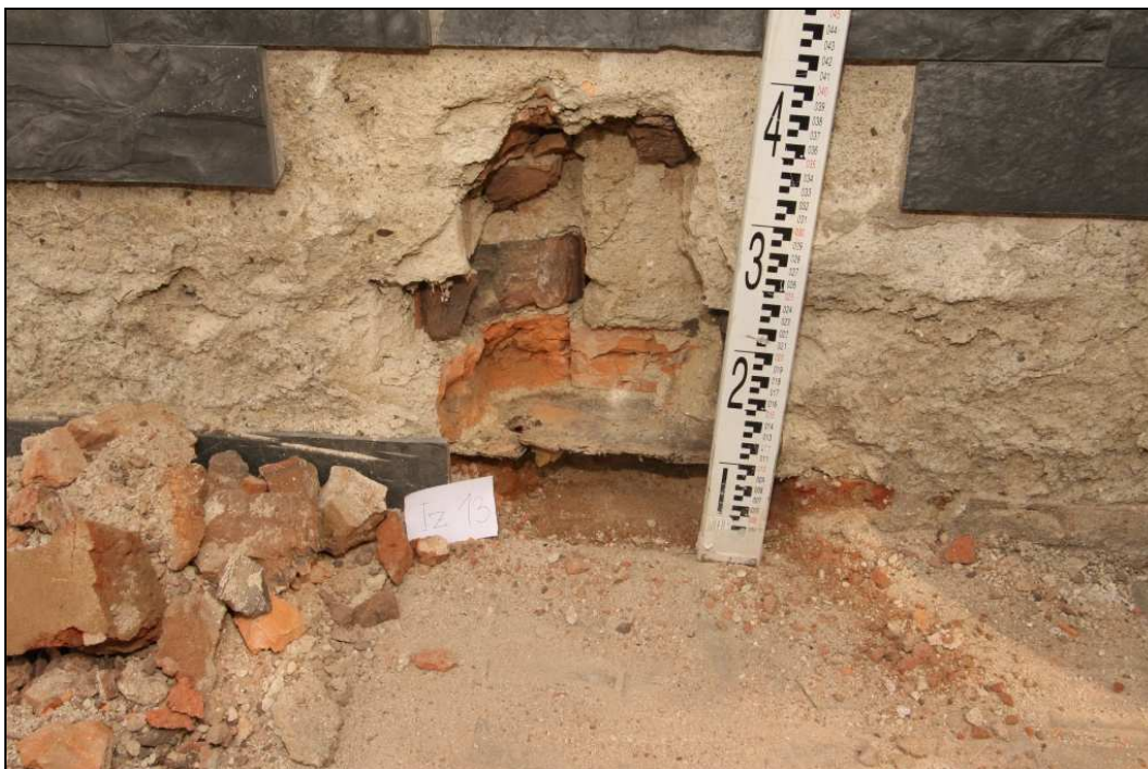
Obr. č. 67 – ověření vodorovné izolace v místě Iz 13
