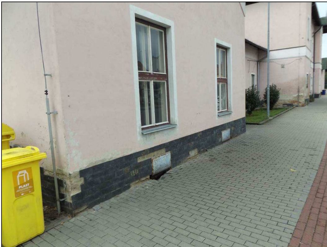
Obr. č. 13 - Okna do sklepa - S obvodová stěna budovy, levá část budovy. Okna jsou sice s plechovými okenními, křídly ale pod jedním z nich zeje otvor do sklepa, kudy dochází ke vtékání povrchové vody za dešťů a kudy dochází k neřízenému větrání.
