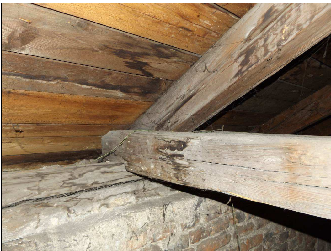
Obr. č. 96 – Prohlídka krovu - pravá část, detail mírně poškozené pozednice
