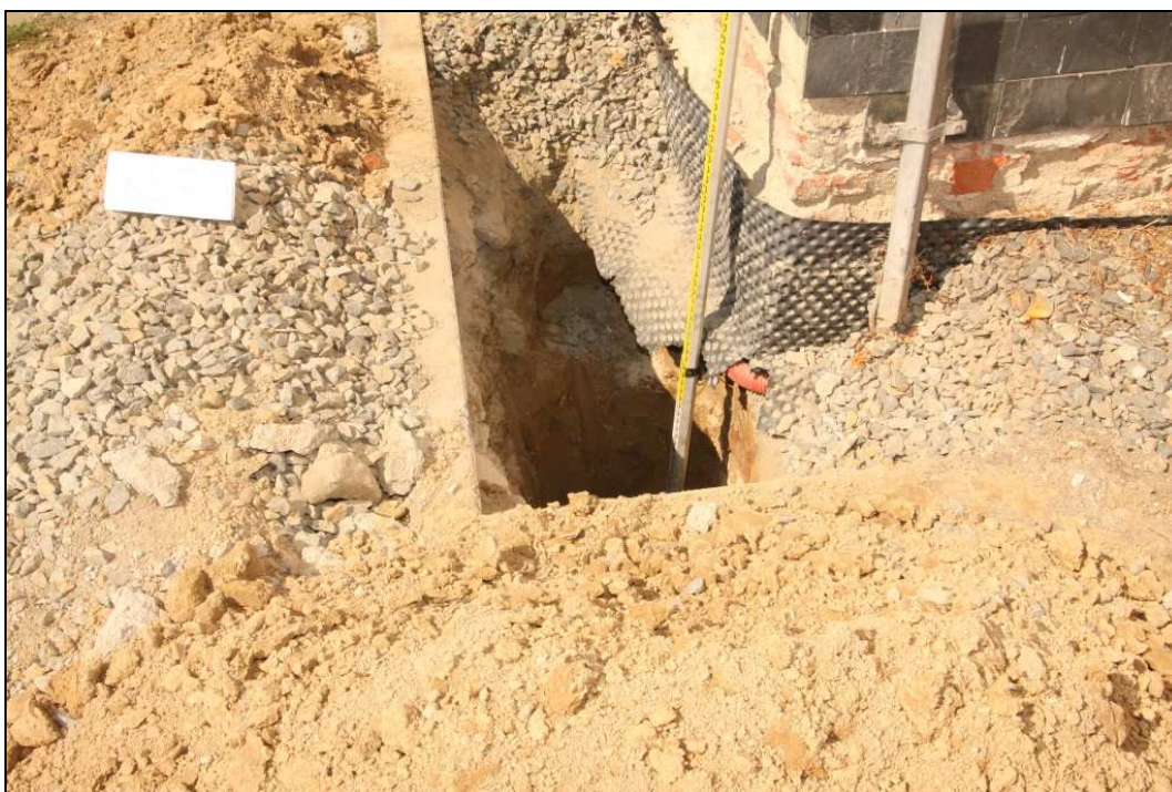
Obr. č. 52 - kopané sondy u líce zdiva, sonda KS3, detail sondy
