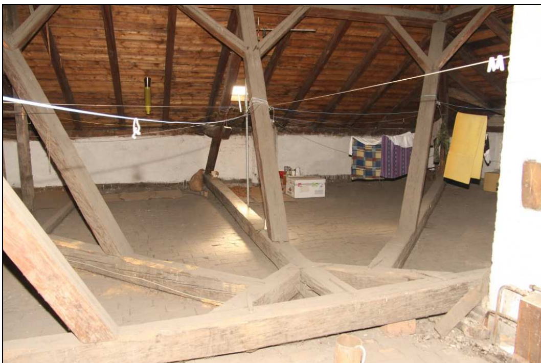
Obr. č. 89 – Prohlídka krovu - střední část, pohled na vazné trámy v místě jejich poškození a dosednutí a opření o podlahu podkroví.
