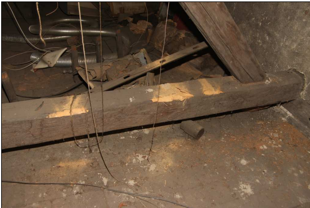
Obr. č. 84 – Prohlídka krovu - Pravá část, poškozený vazný trám
