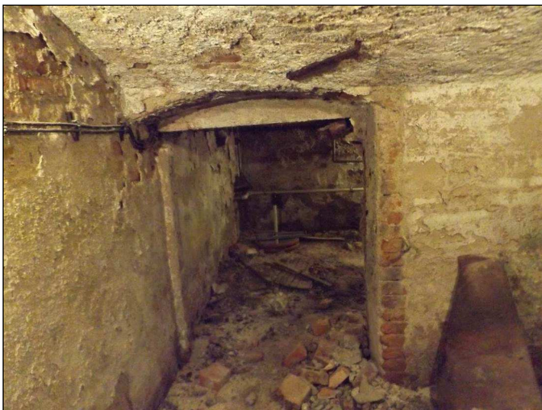
Obr. č. 18 - 1. PP - sklep v pravé části budovy. Typický obrázek. Omítka na zdivu je silně degradovaná a opadává.
