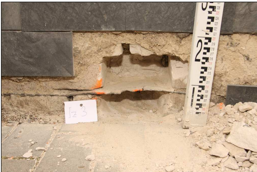
Obr. č. 57 – ověření vodorovné izolace v místě Iz 3
