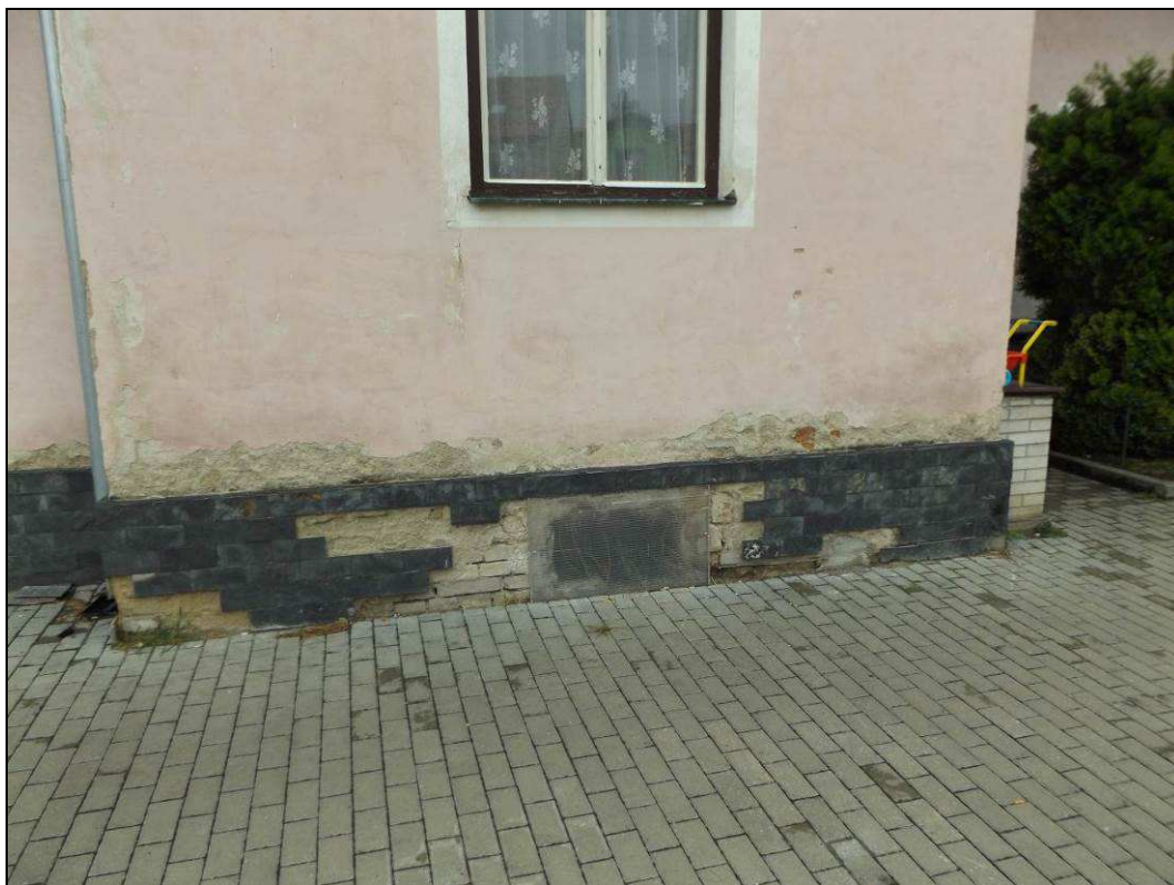
Obr. č. 15 - Okna do sklepa - S obvodová stěna budovy, střední část budovy. Toto okno je provizorně zakryto makrolonovou deskou.
