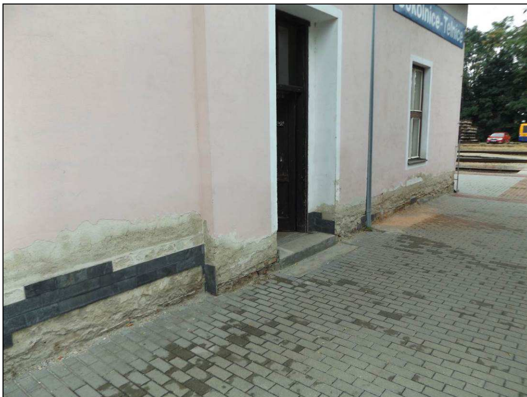
Obr. č. 3 - Z obvodová stěna budovy, vlhkost zdí dosahuje pod parapet okna. Kamenný obklad je většinou již opadáný
